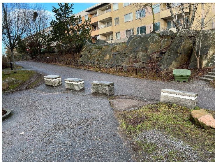
Figur 2.1. Tillfälliga betonghinder som försvårar framkomlighet för räddningstjänst liksom omöjliggör effektiv sopning och sandning av gångbanor.
