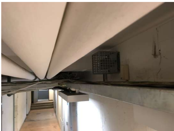
Mosquito-larmens placering i nödutgångarnas passage är dolda och monterade i burar som minimerar möjligheten för obehöriga personer att montera ned dem.
