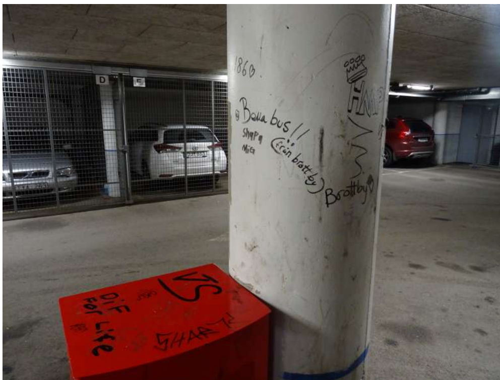
Återkommande problem med klotter i garaget.
