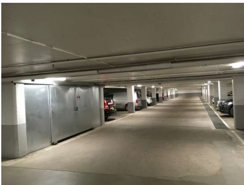
Exempel på Hässelbygaragets ljusmålade miljöer.
