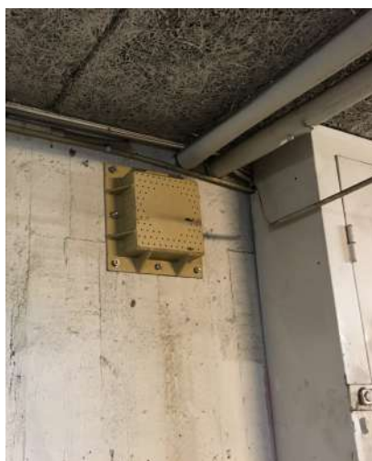
T.h.: installation mosquito-larmen som utfördes parallellt.
