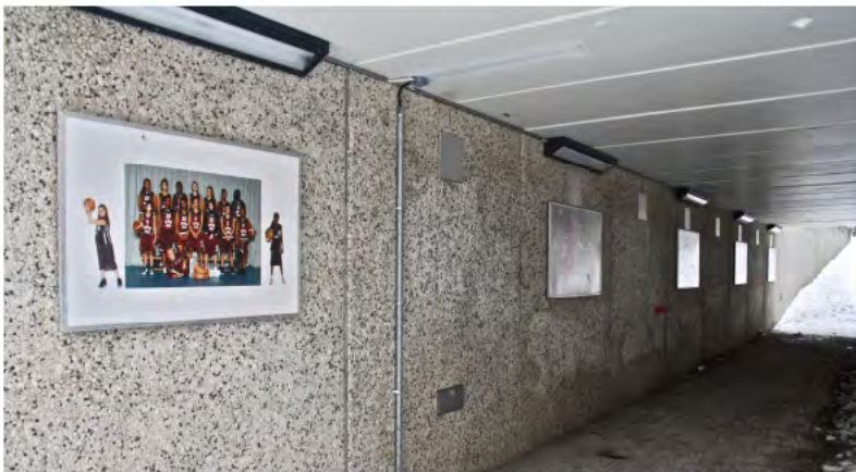
Figur 3. Gångtunnel Nr. 6-0059 med fotokonst under Bredängs allé.
