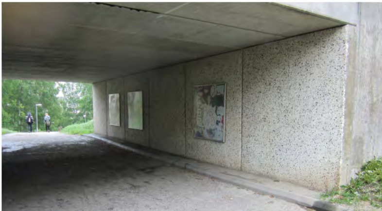
Figur 6. En av gångtunnlarna under Granängsringen i Tyresö.
