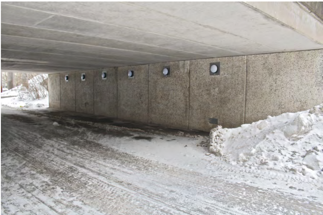
Tunnel utan konst i Skärholmen.
