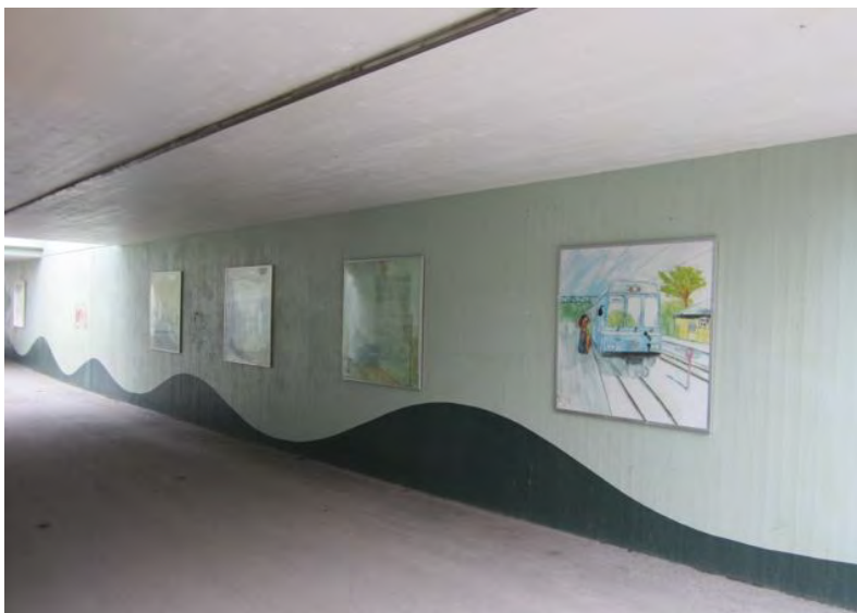
Figur 8. Gångtunneln i Täby, som leder under Roslagsbanan och ligger invid Åsö Gymnasium.
