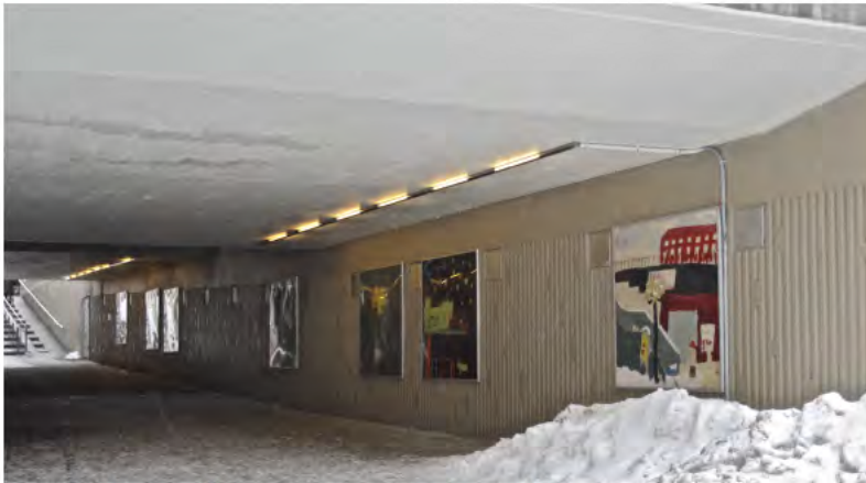
Figur 2. Gångtunnel Nr.6-0055 under Bredängs allé.
