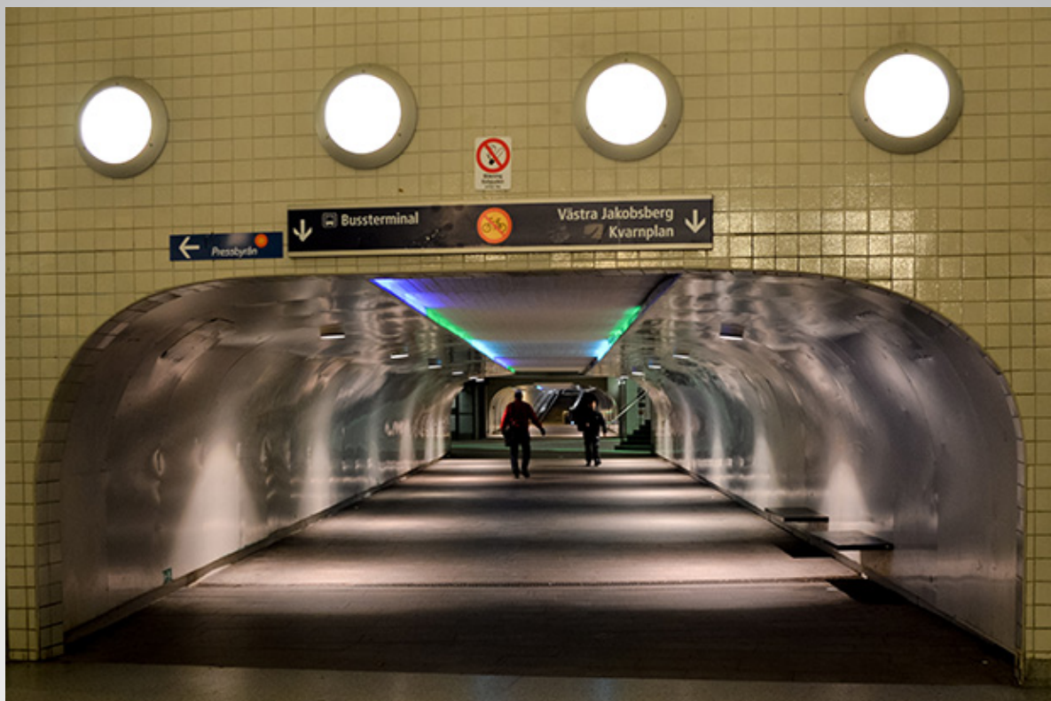
Tunneln under järnvägen från Riddarplatsen i riktning mot Kvarnplan i väster
